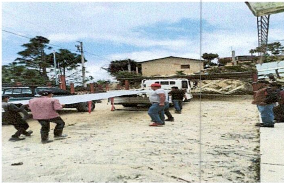
Foto 3: Sustitución por lámina troquelada.
