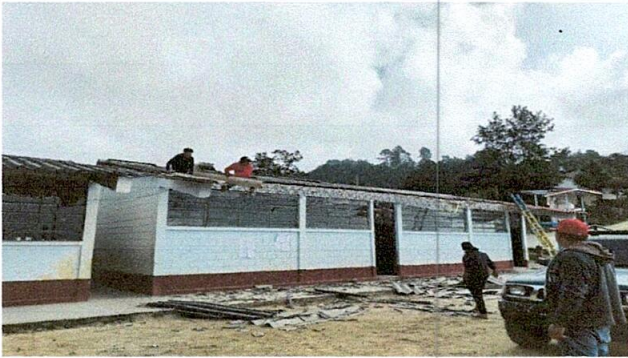
Foto1: Sustitución de lámina.
