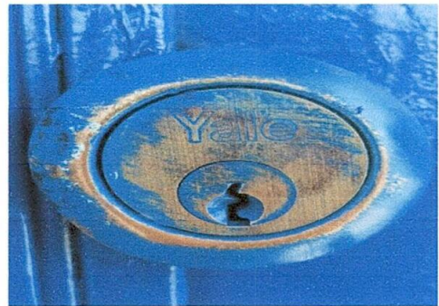
Foto 6: Sustitución de chapa de metal.
