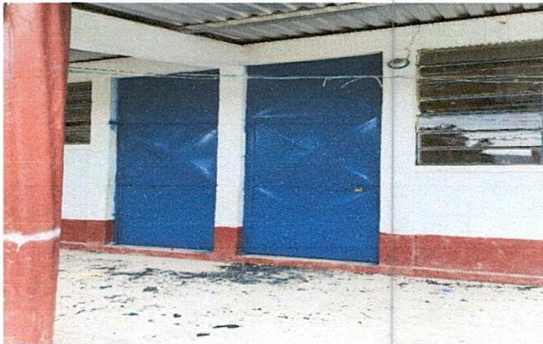
Foto 5: Mantenimiento a puertas de metal, lijado y pintado.
