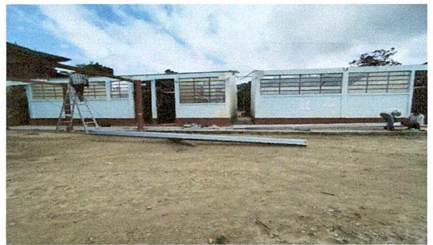
Foto 4: Sustitución de capote de lámina por capote calibre 24
