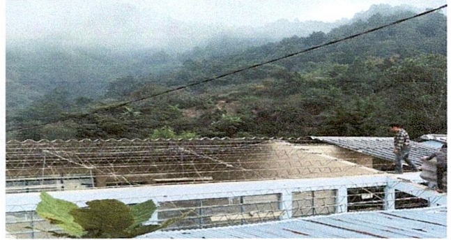
Foto 2: Sustitución de estructura de soporte.
